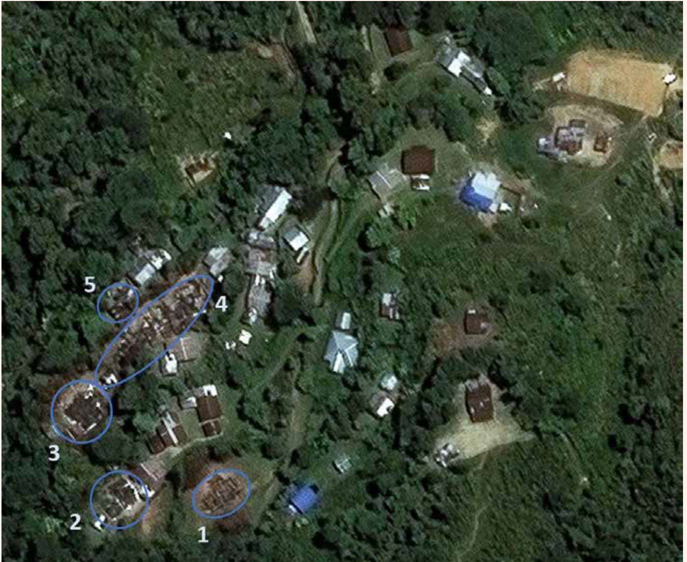
Kerusakan di Desa Oknanggul antara 13 dan 29 September 2021 (foto diambil pada 29 September 2021):
