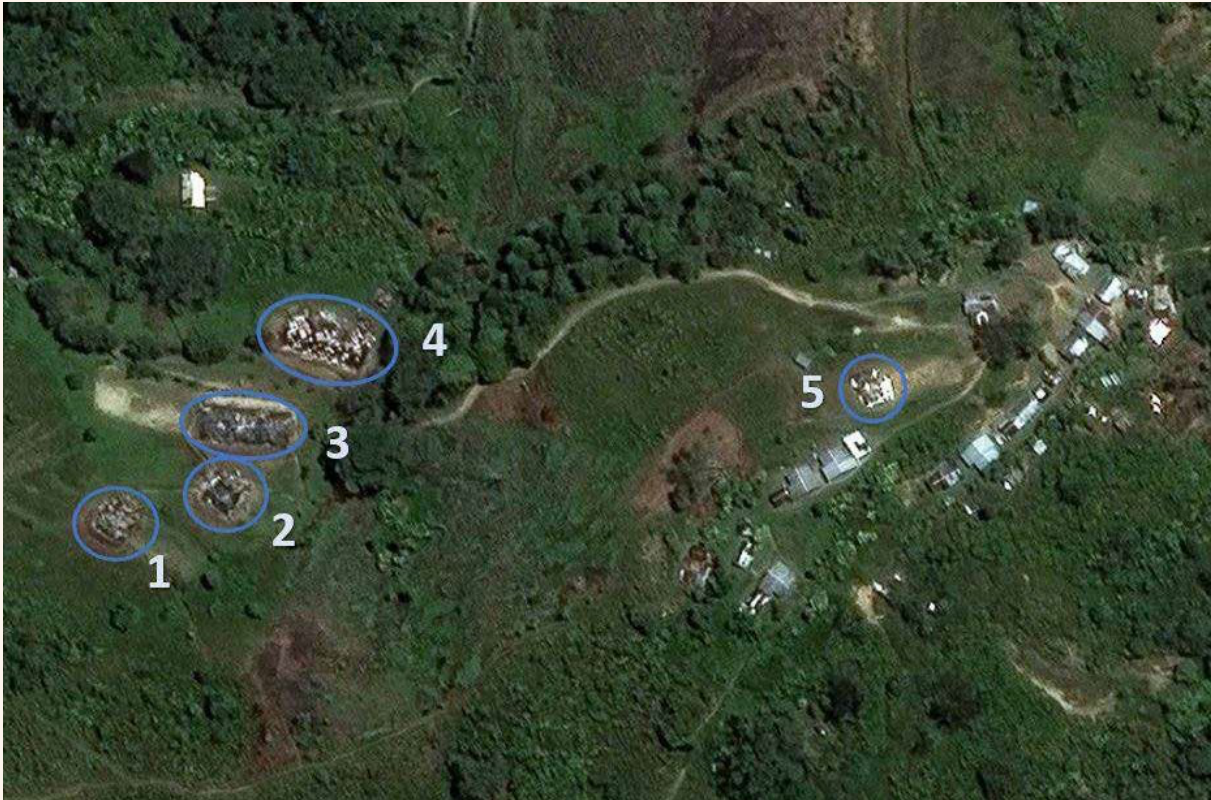
Perusakan di Desa Sopamikma antara tanggal 13 dan 29 September 2021:
